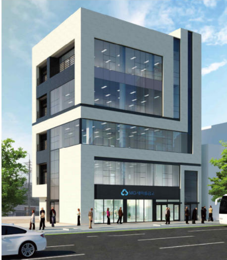
대전동부새마을금고 판암지점 사옥 신축공사
