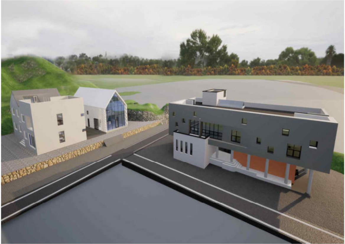
화암동 156 근린생활시설 신축공사 A,B,C동
